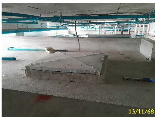
ฝาลังสำรองน้ำใช้ เพื่อการดับเพลิง ชั้นดาดฟ้า
