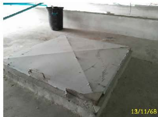
ฝาลังสำรองน้ำใช้ เพื่อการดับเพลิง ชั้นดาดฟ้า
